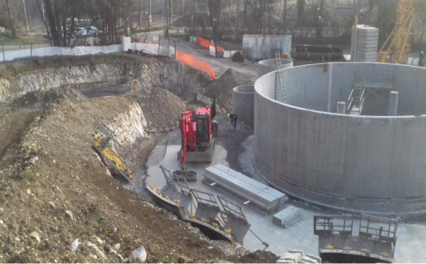
Travaux de construction de la station d'épuration de Salies du Salat
