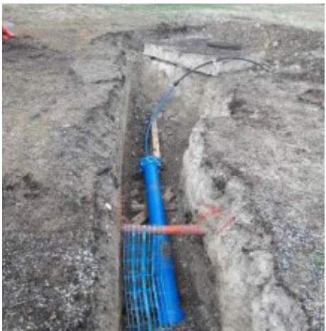
Préparation raccordement château d'eau
