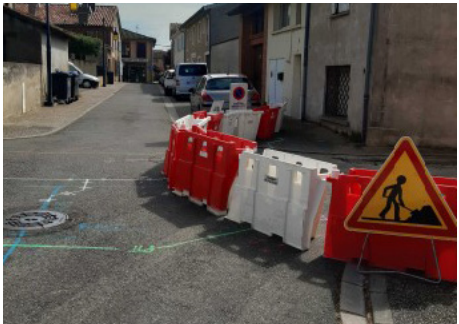
Signalisation route Barrée côté Rue Laurette
