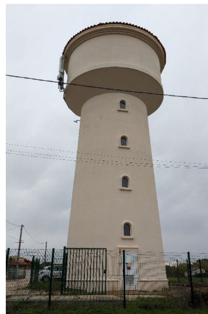
| Réservoir de Villaudric avant / après
